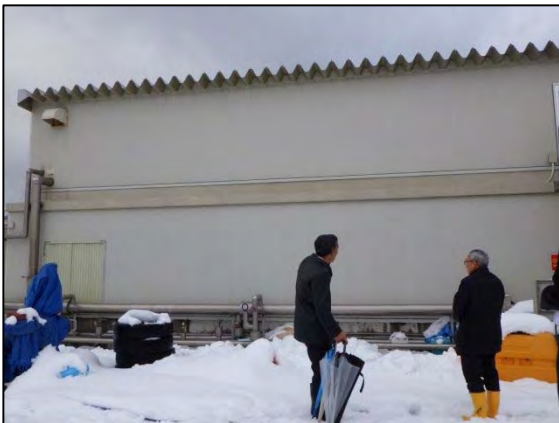
写真3 ガスホルダー・発酵槽
