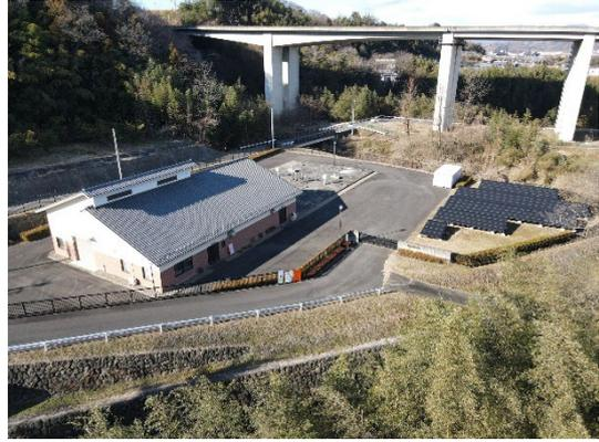
写真4-4-5. 汚水処理施設への太陽光発電施設の設置例
