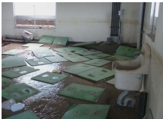
写真－６－７ 左：浸水により浮遊した処理施設の蓋 右：適切に固定された処理施設の蓋
