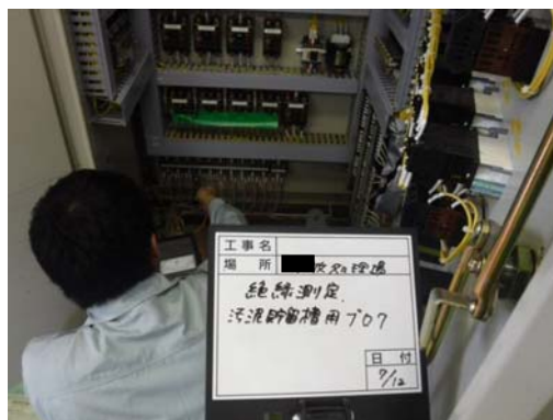
写真－5－3 機械設備の絶縁抵抗値測定
