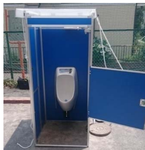
写真－４－１２ マンホールトイレ（上屋・便器） (被災時にマンホールの直上に便器及び仕切り施設等の上部構造物を設置するもの。)
