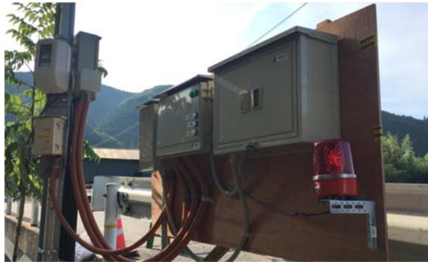
写真－５－５ 応急仮工事（中継ポンプ仮設盤）
