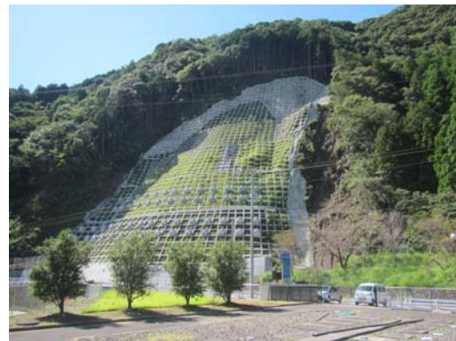
写真－６－６ 左：近傍地山の崩壊、右：法面保護工（右）
