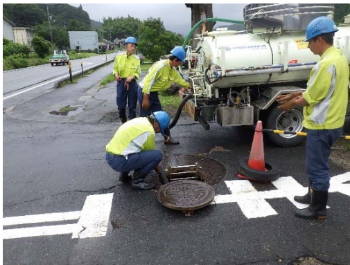
写真－３－８ 中継ポンプ施設被災時の汚水の引抜き状況
