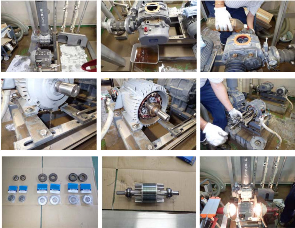
写真－４－２ ブロワ分解整備状況
