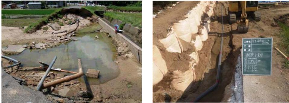
写真－４－８ 左：真空用塩化ビニル管の被災、右：塩化ビニル管（RR管）での仮復旧
