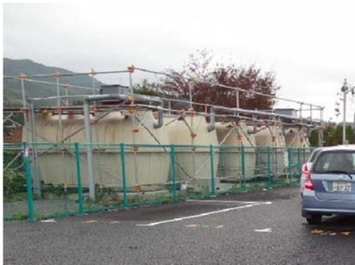
写真－４－５ 応急仮設住宅に設置される浄化槽（参考）
