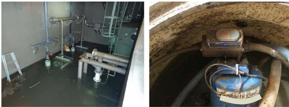
写真－４－７ 左：真空ステーション浸水状況、右：真空弁コントローラ浸水状況
