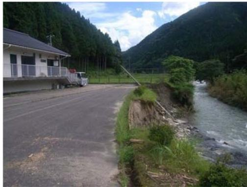
写真－3－5 汚水処理施設周辺の河川護岸の崩壊
