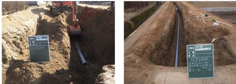
写真－４－９ 左：仮復旧管（RR管）の撤去、右：真空用塩化ビニル管での本復旧
