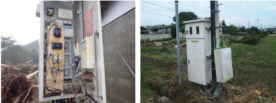
写真－４－６ 仮設盤による応急復旧
