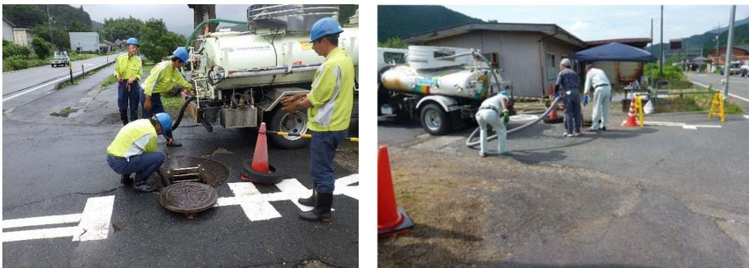
写真－３－８ 中継ポンプ施設被災時の汚水の引抜き状況
