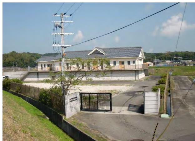
写真－６－９ 洪水位を考慮した建屋（１階部分を高所化）
