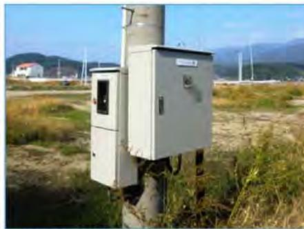
いち早く復旧した電柱に仮設の受電盤、制御盤を架設
