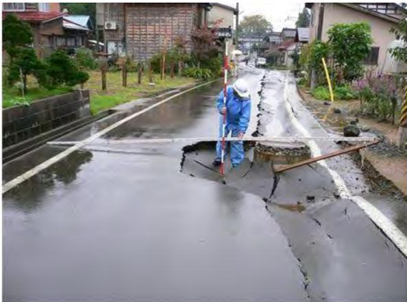
写真-3-1 管路の緊急点検・調査の状況
