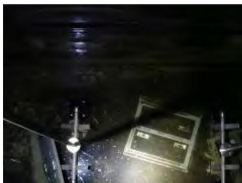
写真－5－12 左：流量調整槽の土砂混入（污水計量槽の四角堰）
