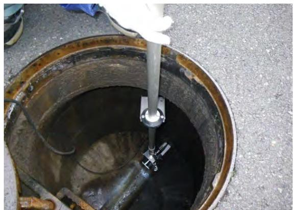
写真一五二 二次調査（管口カメラ調査）器具と状況
