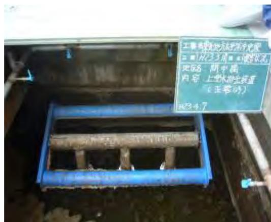
写真-5-7 上澄水排出装置の変形
