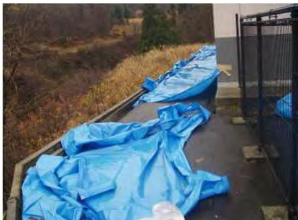
写真－3－6 汚水処理施設周辺の崖崩れ保護
