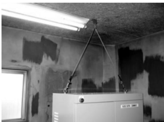
写真-6-10 制御盤の転倒防止
