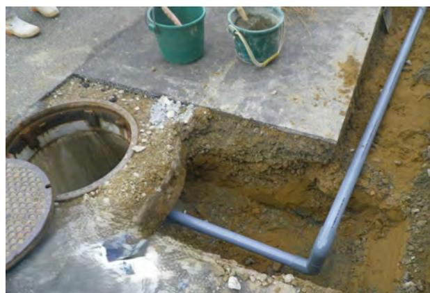
写真－４－３ 仮設ポンプによる応急復旧
