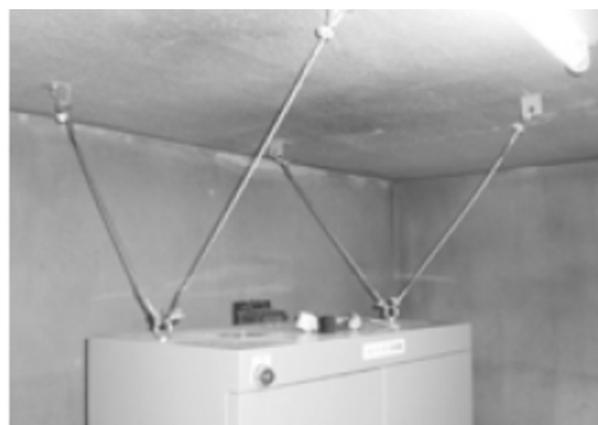
写真-6-11 制御盤の転倒防止
