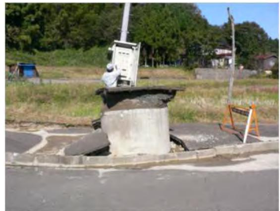
写真-3-2 中継ポンプの緊急点検・調査状況
