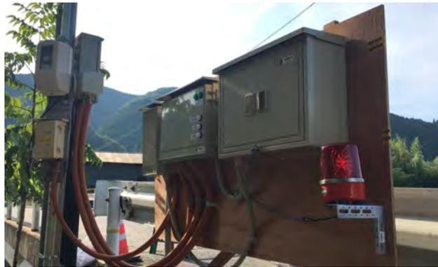
写真－5－10 応急仮工事（中継ポンプ仮設盤）
