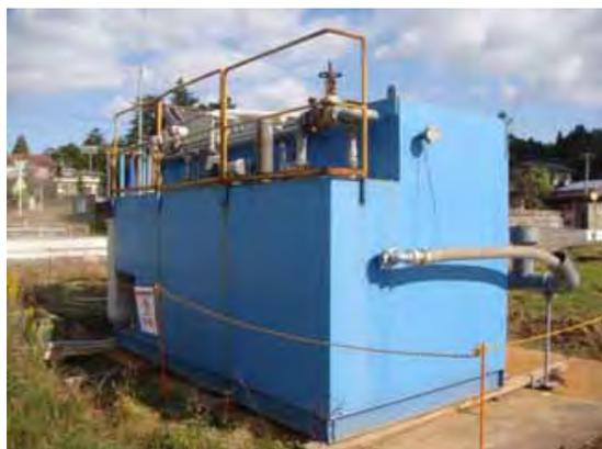
写真-4-7 ユニット型仮設污水处理施設
