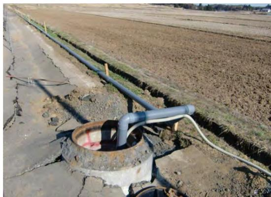
写真-4-2 仮設配管による対応
