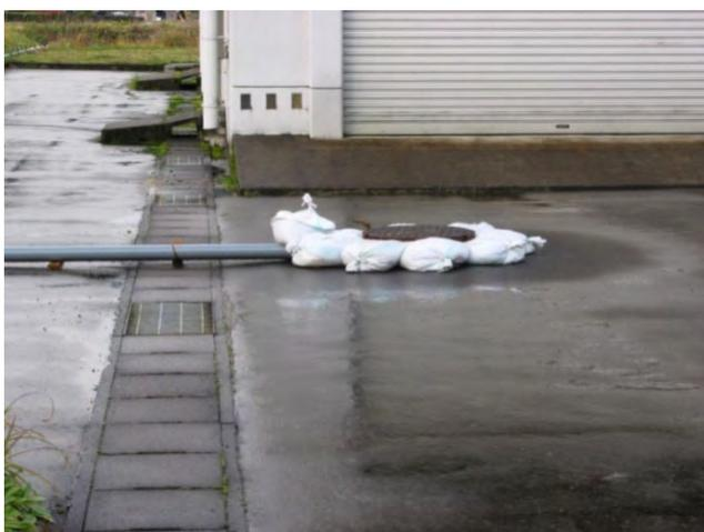
写真－５－９ 流入管路の応急復旧の状況
