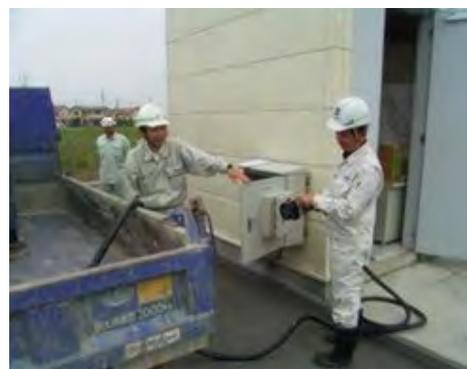
写真－6－13 外部電源用の非常用電源受電盤
