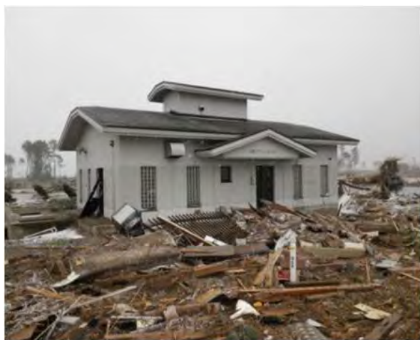
写真－3－7 津波により瓦礫に埋まった 污水处理施設
