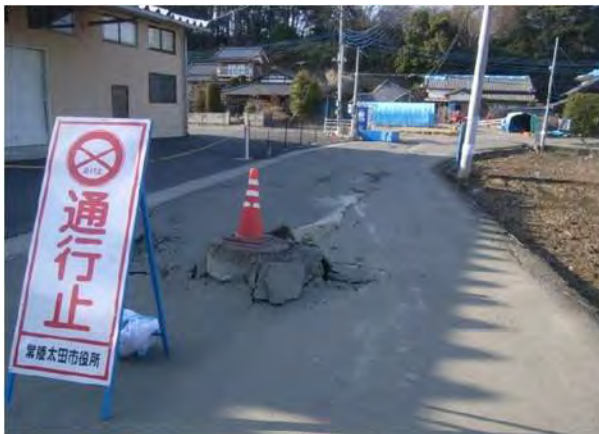
写真－３－４ 管路施設の緊急措置の状況
