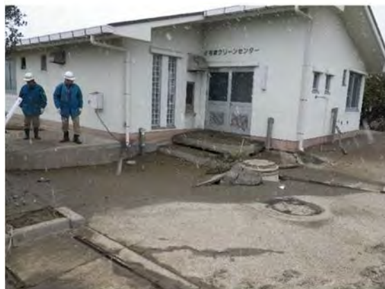
写真－３－３ 汚水処理施設の緊急調査状況 (東北地方太平洋沖地震)
