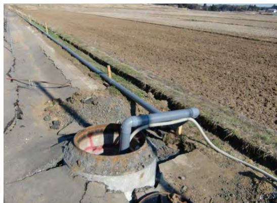
写真-4-2 仮設配管による対応
