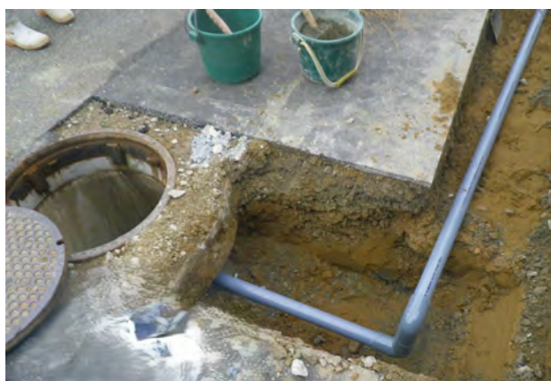
写真－４－３ 仮設ポンプによる応急復旧
