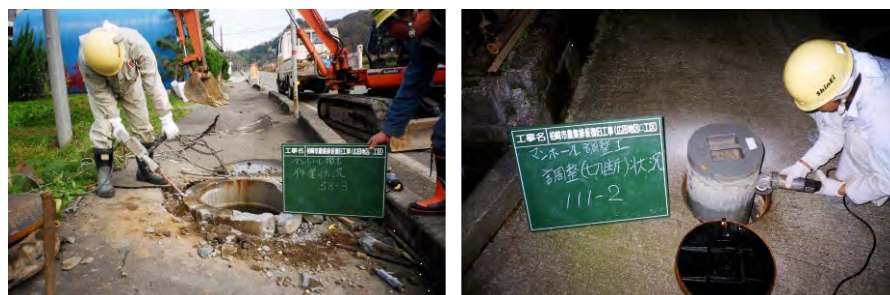
写真－５－８ マンホールの切り下げ状況
