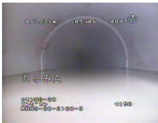
写真－５－５ 管内カメラ（テレビカメラ）による管路内の滞水状況（写真左）とコンクリート管の管体側面のひび割れ及び浸入水の状況（写真右）
