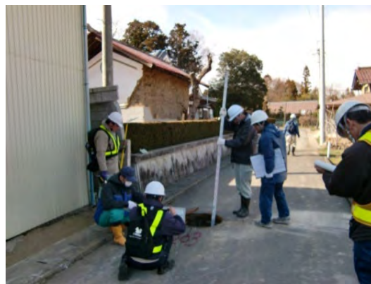
写真－５－１ 管路施設の一次調査の状況
