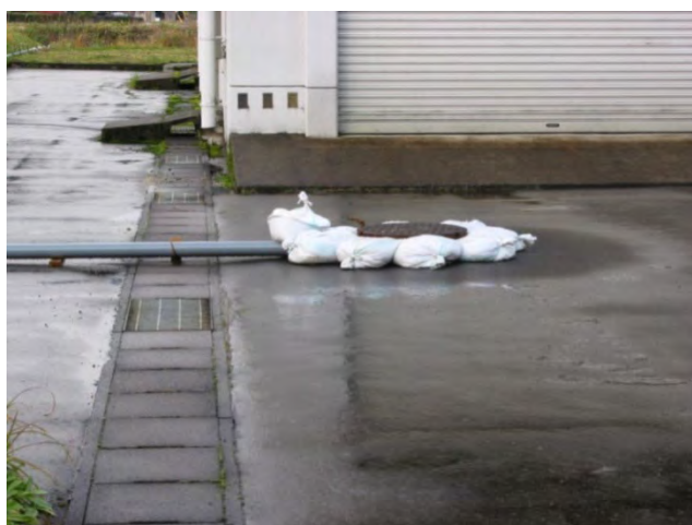
写真－５－９ 流入管路の応急復旧の状況
