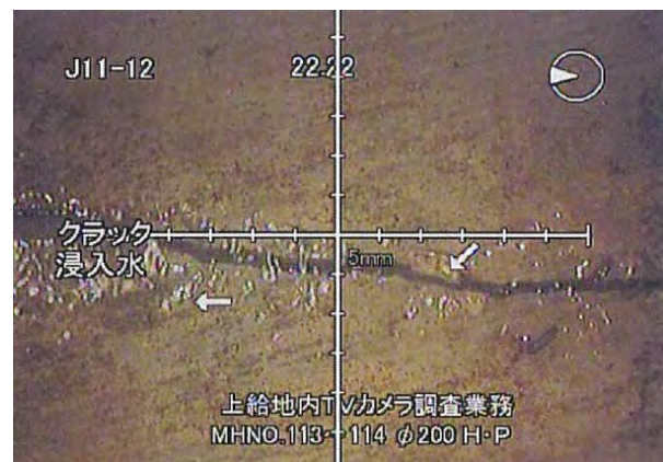
写真－５－５ 管内カメラ（テレビカメラ）による管路内の滞水状況（写真左）とコンクリート管の管体側面のひび割れ及び浸入水の状況（写真右）
