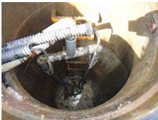
写真-4-1 仮設ポンプによる対応
