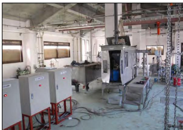
写真 48 仮設制御盤等の設置《応急復旧》
