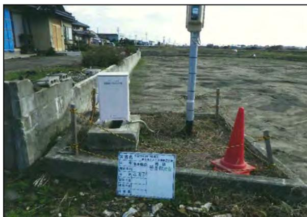
写真 41 中継ポンプ仮設制御盤等の設置《応急復旧》
