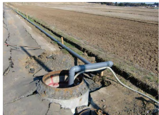
写真-4-2 仮設配管による対応
