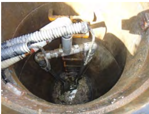
写真-4-1 仮設ポンプによる対応
