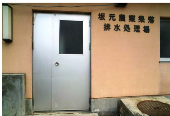
写真-6-5 污水处理施設建屋 ドアガラリなし
