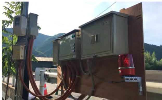
写真－5－10 応急仮工事（中継ポンプ仮設盤）
