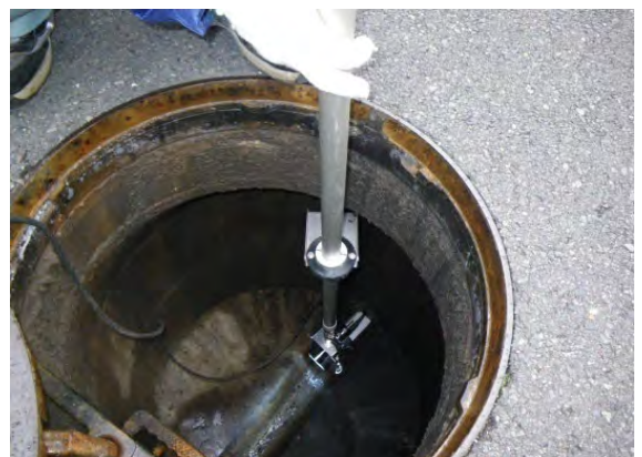
写真一5-2 二次調査（管口カメラ調査）器具と状況
