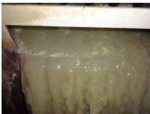
写真－５－１２ 左：流量調整槽の土砂混入（污水計量槽の四角堰） 右：水槽内への覆蓋の落下（汚泥貯留槽）
