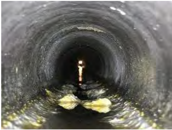
写真－５－３ 二次調査（管口カメラ調査）による管路に変状がない状況（写真左、光が丸く見える）と管路が上方向にたるんでいる状況（写真右、光が見えない）
