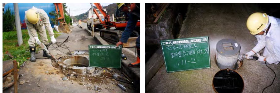
写真－５－８ マンホールの切り下げ状況
