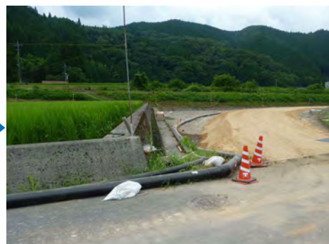
写真－5－11 応急仮工事（左：管路被災状況、右：仮設道路と仮配管）
