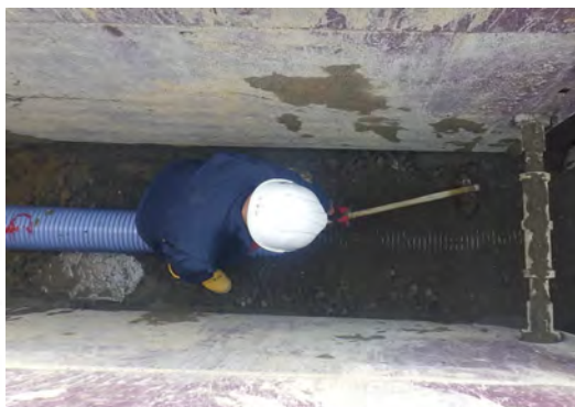
固化改良土埋戻工法による施工
