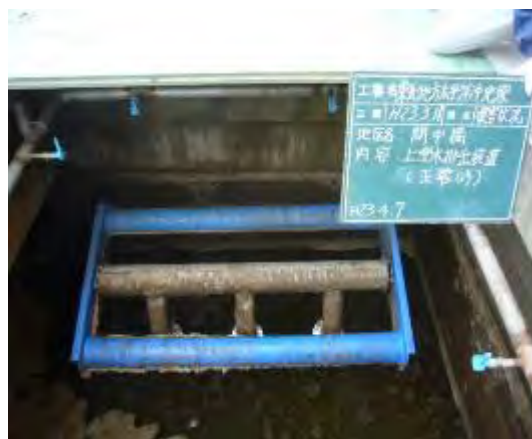
写真-5-7 上澄水排出装置の変形
