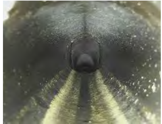
写真－５－３ 二次調査（管口カメラ調査）による管路に変状がない状況（写真左、光が丸く見える）と管路が上方向にたるんでいる状況（写真右、光が見えない）
