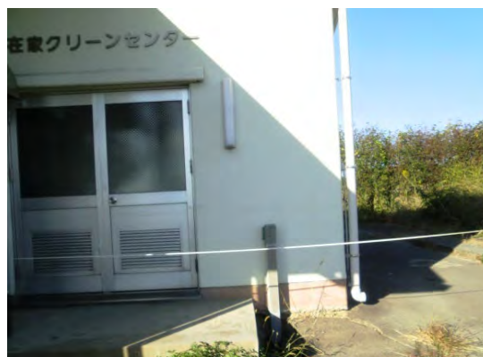
写真-6-6 污水处理施設建屋 ドアガラリあり
