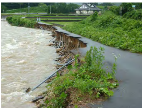
写真－5－11 応急仮工事（左：管路被災状況、右：仮設道路と仮配管）
