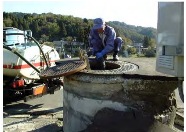
写真－３－５ 管路マンホールの緊急措置 の状況
