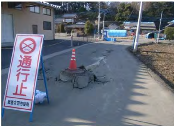
写真－３－４ 管路施設の緊急措置の状況
