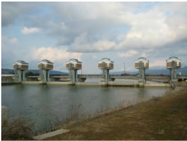
はくい がわしおどめすいもん 羽咋川潮止水門(石川県)おうちがた 邑知瀧地区
