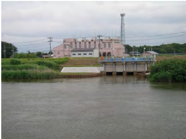
しろね 白根排水機場(新潟県)しろねごう 白根郷地区
