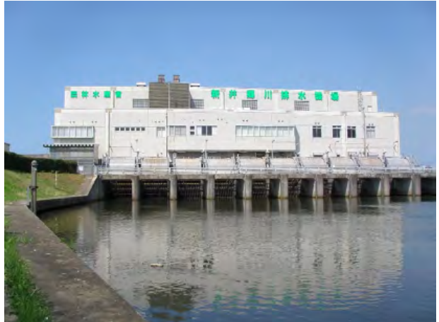
にいごうがわ 新井郷川排水機場(新潟県)あがのがわ 阿賀野川地区
