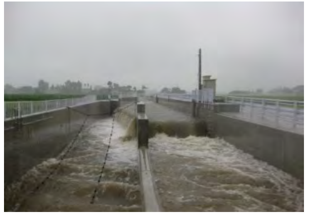
排水分水ゲート
