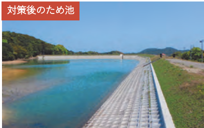
対策後のため池
