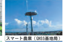
スマート農業（GNSS基地局）
