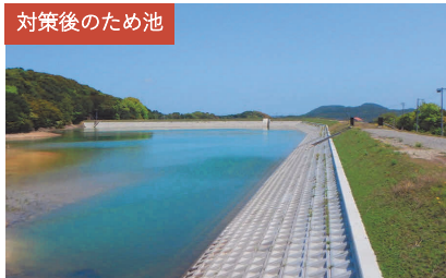
対策後のため池
