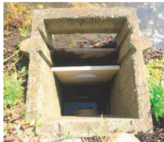
田んぼダムの取組例 (調整板の設置)
