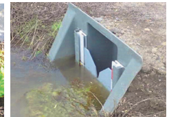
流出を抑制する落水量調整装置の例
