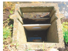
流出を抑制する落水量調整装置の例
