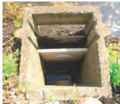
田んぼダムの取組例 (調整板の設置)
