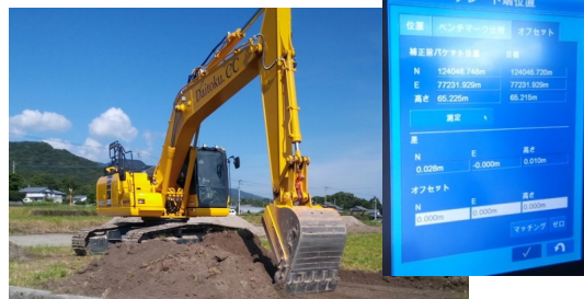
ICT建設機械による掘削工
