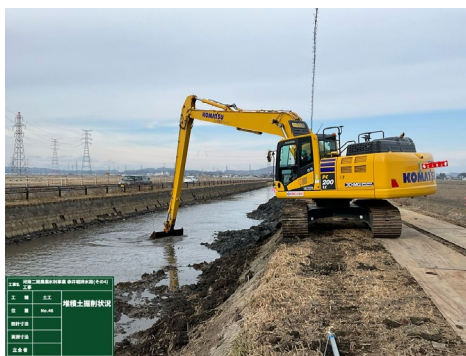
堆積土の掘削
