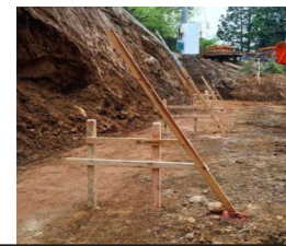
設計図に合わせて丁張り設置
