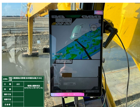
マシンガイダンスによる施工
