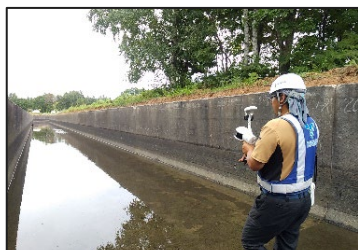
ハンドスキャナーによる起工測量
