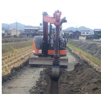
バックホウによる施工
