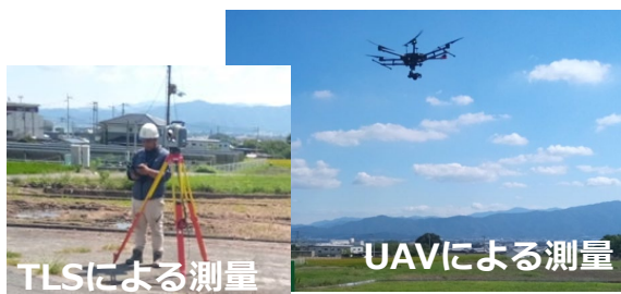
3次元起工測量
