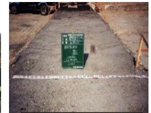
出来形管理の状況
