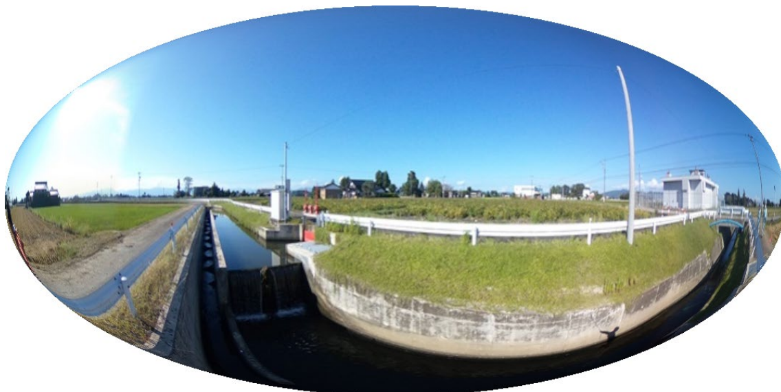
図 3-10 現地調査において活用する 360° パノラマ画像
