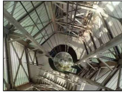
取水塔内部 (複雑な構造)
