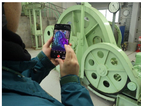
図3.24 携帯型機器での計測状況
