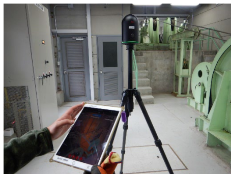
図 3.27 据置型機器での計測状況
