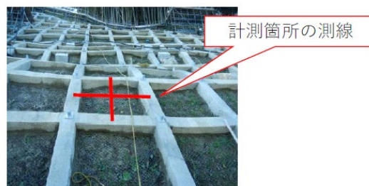
図 9－5 梁間隔の算出方法
