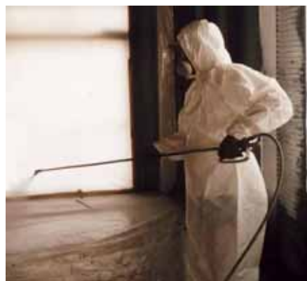
(薬液散布による石綿の湿潤化)
