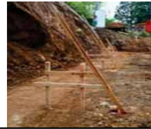
設計図に合わせて丁張り設置
