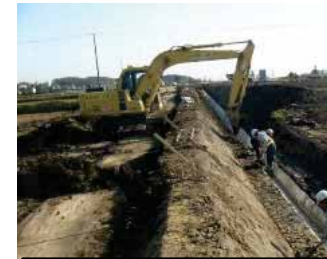
丁張りに合わせて施工
