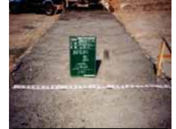
出来形管理の状況
