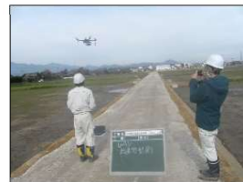
UAVによる3次元測量
