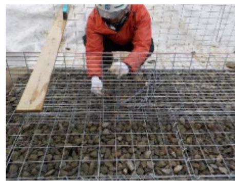
かが組立・据付け
