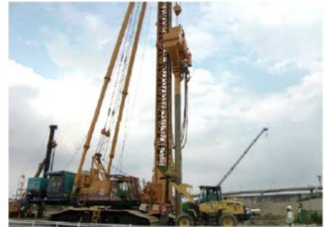
軟弱地盤処理工
