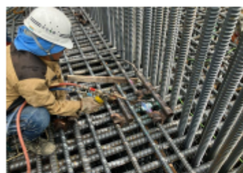
ガス圧接継手
