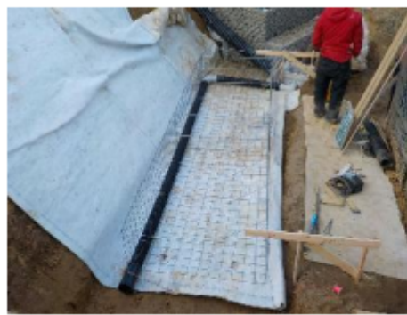
吸出し防止材設置
