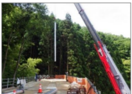
鋼管建込状況
