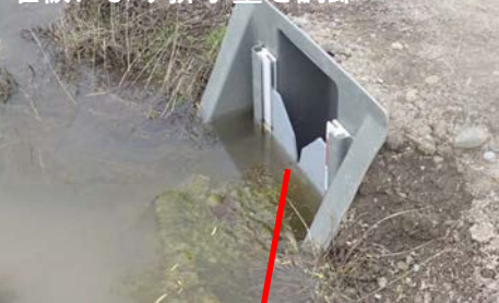
堰板により排水量を調節
