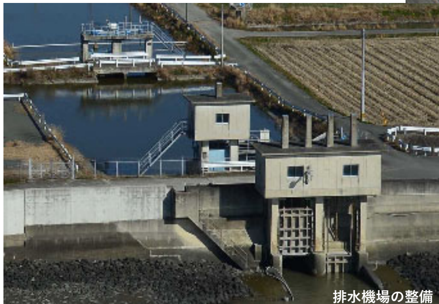
堰板により排水量を調節
