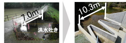
豪雨対策（洪水吐きの改修）の先行整備（例） ※地震対策は豪雨対策完了後に実施
