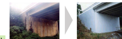
老朽化対策を実施した農道橋
