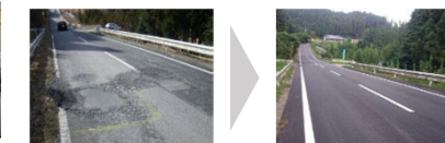
路面改良を実施した農道
