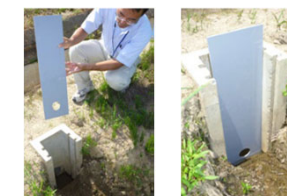
調整板設置状況 排水柵（調整板挿入） （福井県鯖江市）
