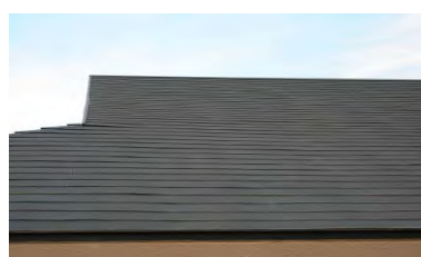
(住宅屋根スレート)＊＊＊＊
