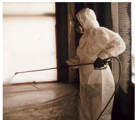
（薬液散布による石綿の湿潤化）
