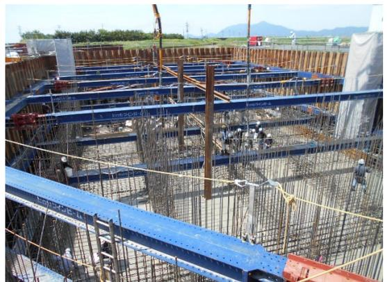
高強度部材の切梁による施工性向上（写真3）
