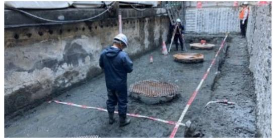
止水対策後の仮締切内の状況（写真2）
