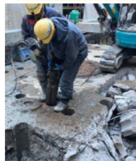
仮締切内エプロン部取壊し状況（写真3）
