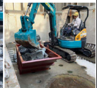
仮締切内エプロン部取壊し状況（写真3）
