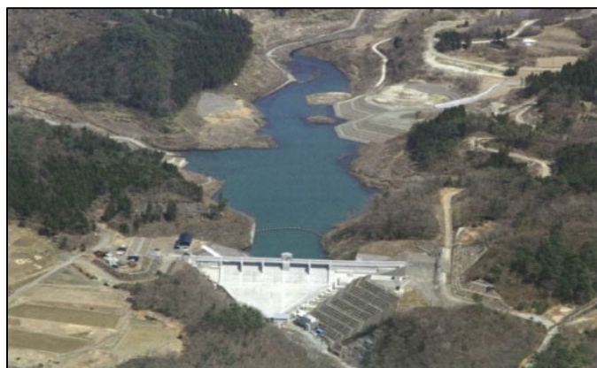
外山ダム全景（下流面）
