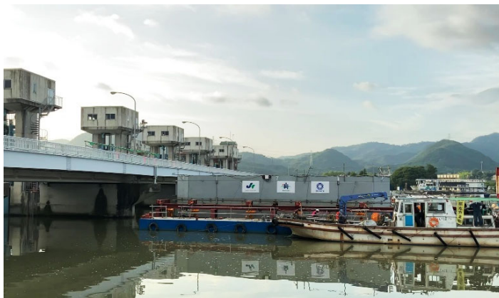
仮締切設置状況（写真1-1）
