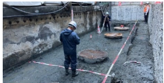
止水対策後の仮締切内の状況（写真2）
