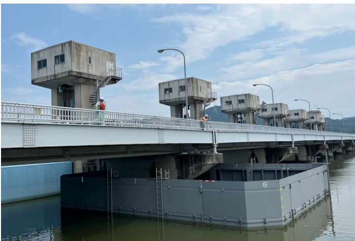
仮締切設置完了（写真1-2）
