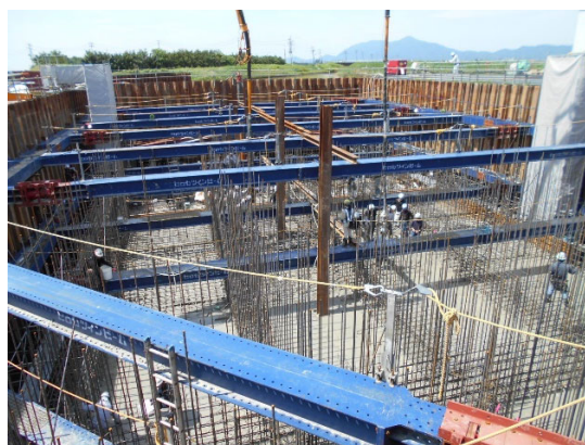
高強度部材の切梁による施工性向上（写真3）
