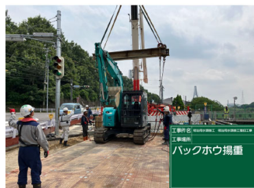
バックホウ本体に損傷なく揚重できる専用吊り具
