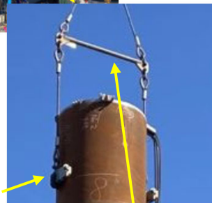
スプレッドビーム 吊りワイヤーのねじれ、 損傷を防ぐ吊り具
