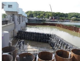
連続箱型鋼製枠(完成)
