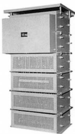
図 3.1-19 屋内開放形始動抵抗器外観例
