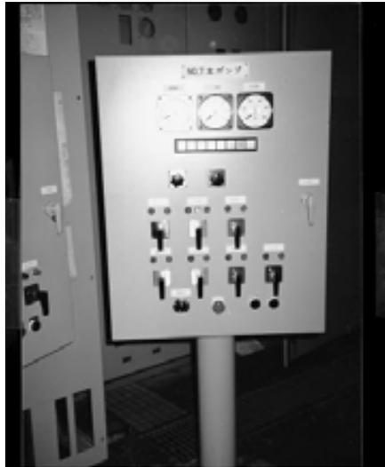
図 3.3-51 主ポンプ用機側操作盤外観例
