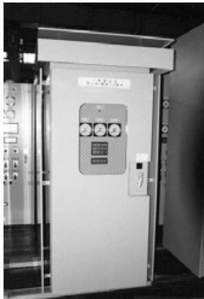
図 3.3-52 ゲート用機側操作盤(自立形)外観例
