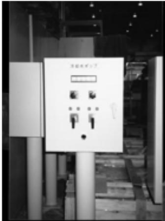
図 3.3-53 補機用機側操作盤外観例
