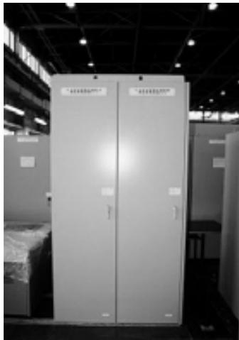
図 3.3-54 補助継電器盤外観例
