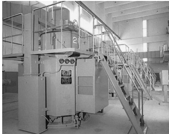
図 3.1-2 立軸保護防滴自由通流形巻線形電動機の外観例 (形式表現：IP22 IC0)
