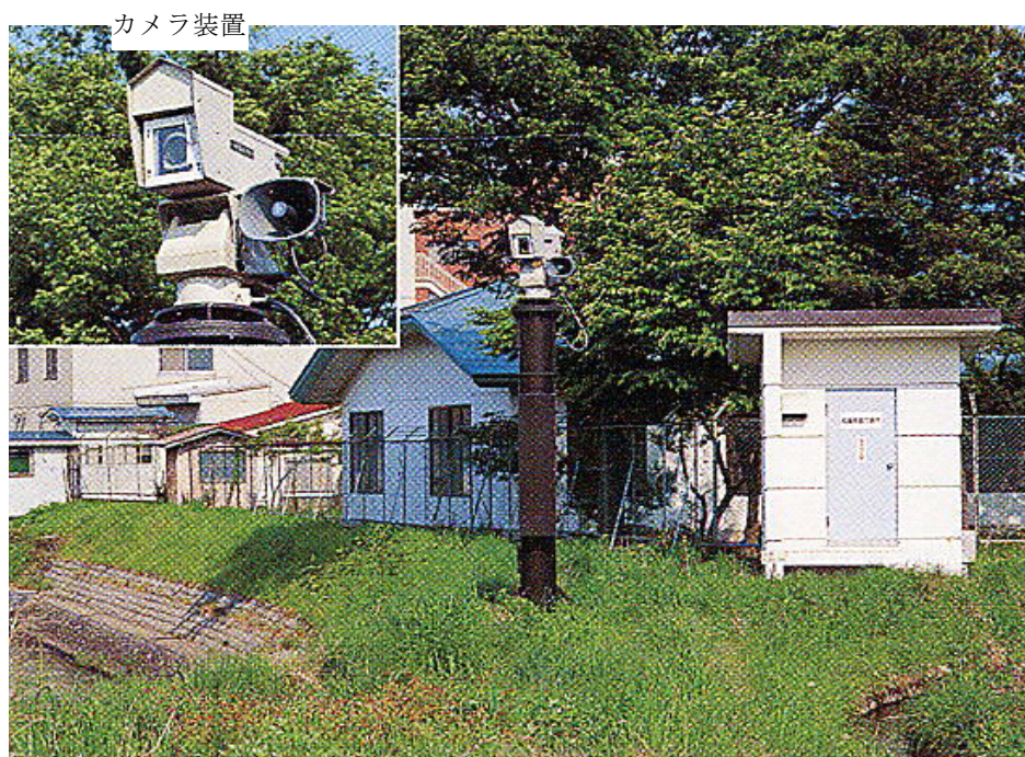
図 1.1-7 CCTV 装置外観（例）
