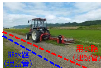
営農作業上の障害を除去する用排水路の管路化
