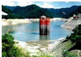
ダム貯水池の状況
