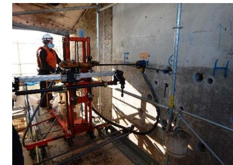
ゲートの耐震対策（鉄筋挿入）
