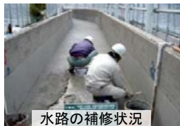
水路の補修状況
