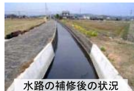
水路の補修後の状況
