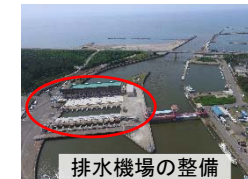
排水機場の整備
