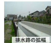
排水路の拡幅
