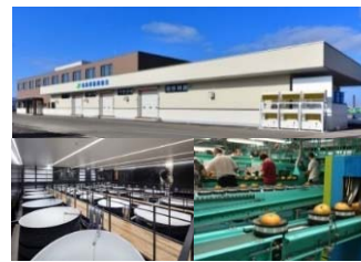
集出荷・貯蔵・加工施設
