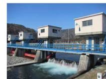
頭首工での越流による水膜振動等による音の発生
