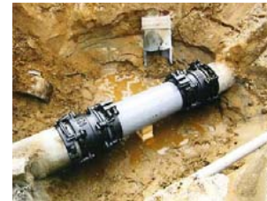
漏水防止のための整備
