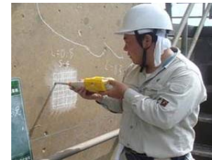
老朽化した施設の機能診断
