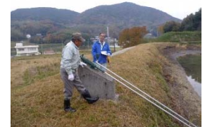
ため池の現地パトロール
