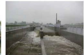
(排水分水ゲート)
