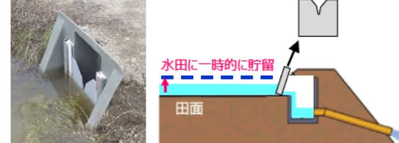
堰板等を設置し、雨水を水田に一時的に貯留
