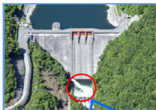
放流設備からの放流状況
