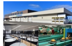
集出荷・貯蔵・加工施設
