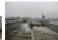
(排水分水ゲート)
