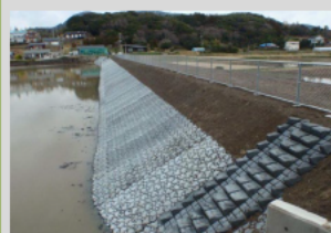
ため池護岸の整備
