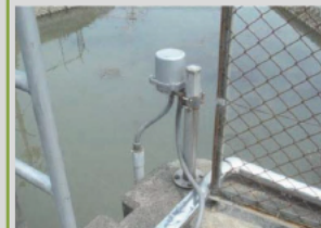
水位計の設置
