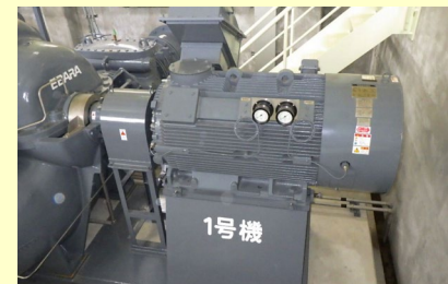
高効率電動機への更新
