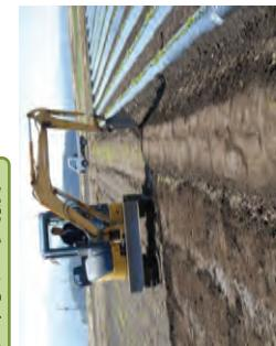
堰板等を設置し、雨水を水田に一時的に貯留
