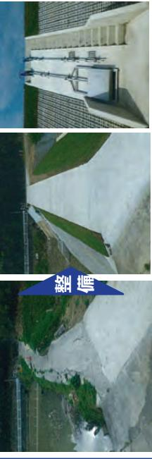
●復旧と併せたため池改修（緊急放流工の設置）例
