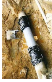
漏水防止のための整備
