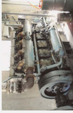
施設整備補修
