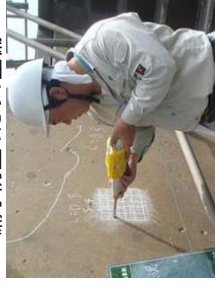
老朽化した施設の機能診断
