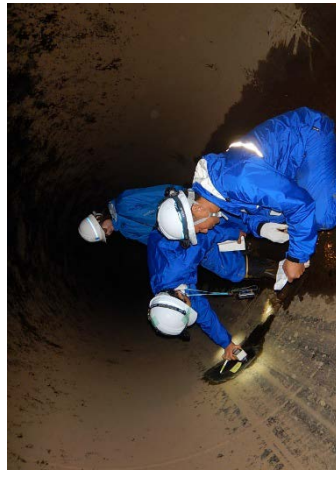
管水路の機能診断
