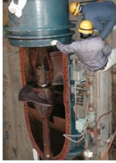
〔ポンプ施設の劣化状況調査〕
