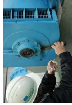
〔ポンプ設備を分解することなく、潤滑油採取による診断技術確立〕
